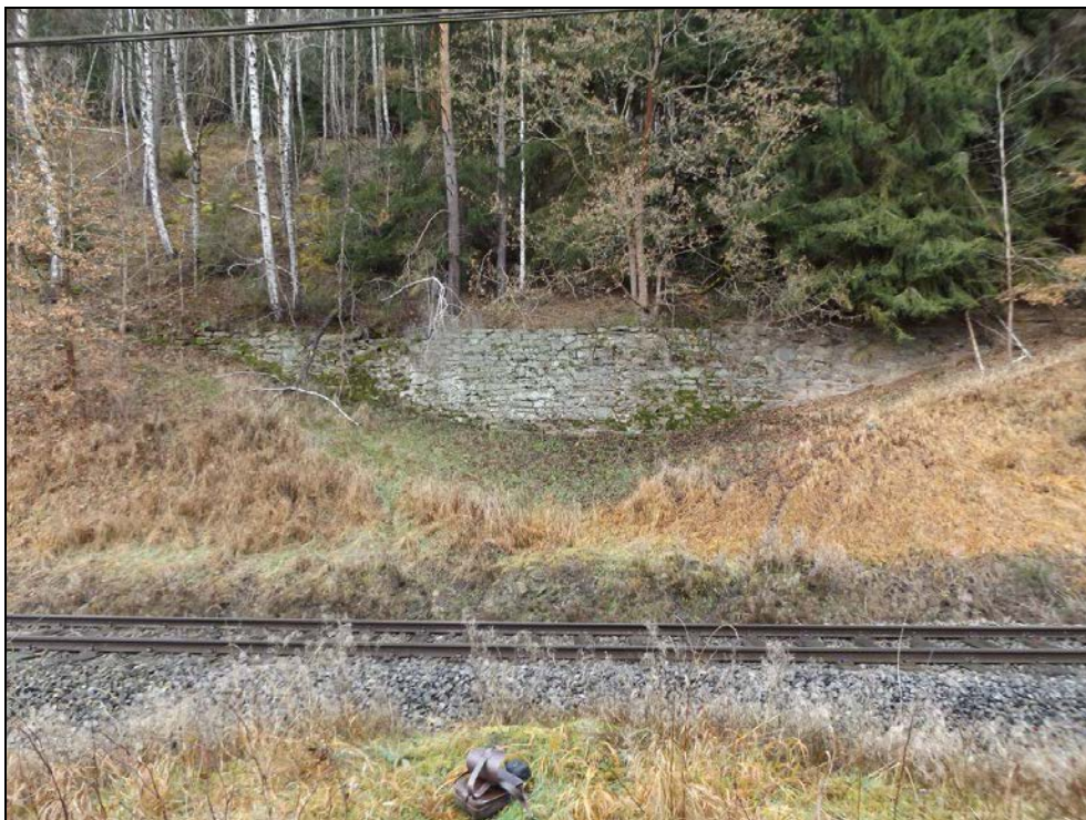
Obr. č. 1 - čelní pohled na objekt zárubní zdi, která je vzdálená cca 14,5 m od osy koleje. V tomto místě (viz foto) byl původně s největší pravděpodobností přejezd a zárubní zeď vymezovala prostor pod patou svahu pro polní a lesní cestu
